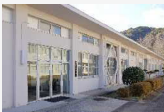
ものづくりセンター（建物外観）
