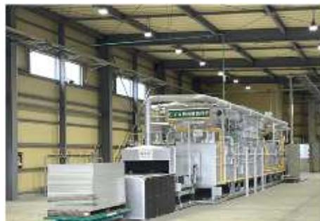
太陽光パネルリサイクル
