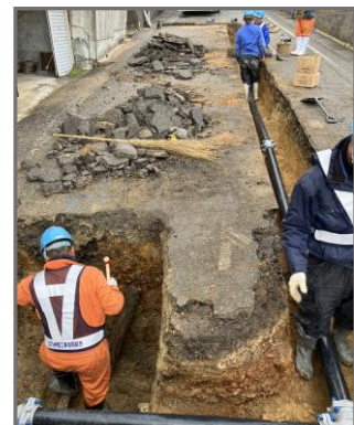
輪島市での復旧作業の様子
