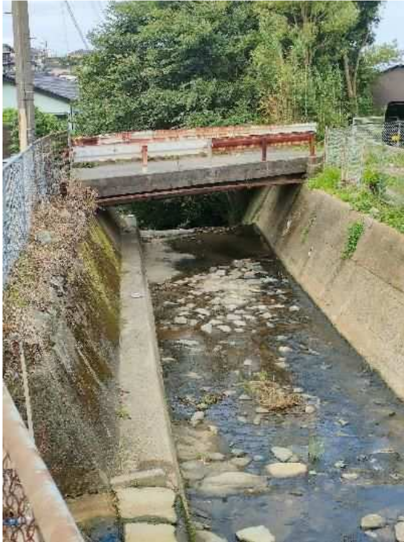
【土地への進入路である橋梁】
