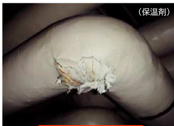
石綿含有断熱材等
