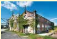
④ 遠賀川水源地ポンプ室
