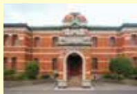
① 官営八幡製鐵所 旧本事務所
