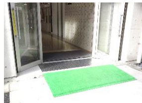
段差解消のためのスロープ
