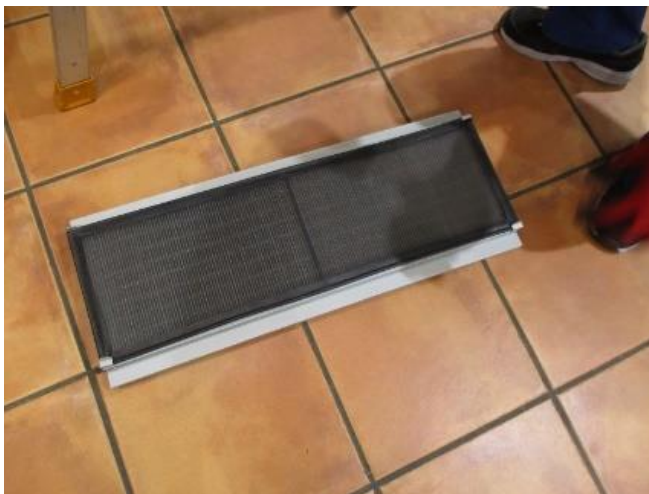
【落下した空調フィルター】
