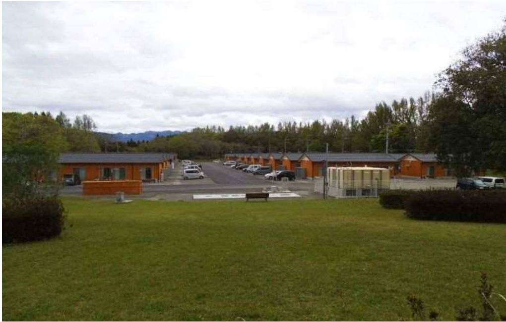
市内各所に設けられた仮設団地
