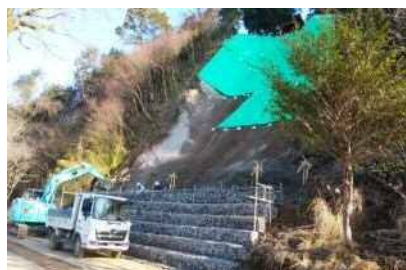
大規模な土砂崩れが発生した城郭法面の復旧
