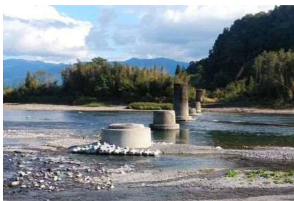
倒壊・流出した護岸・橋梁
