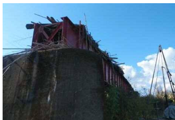
倒壊・流出した護岸・橋梁
