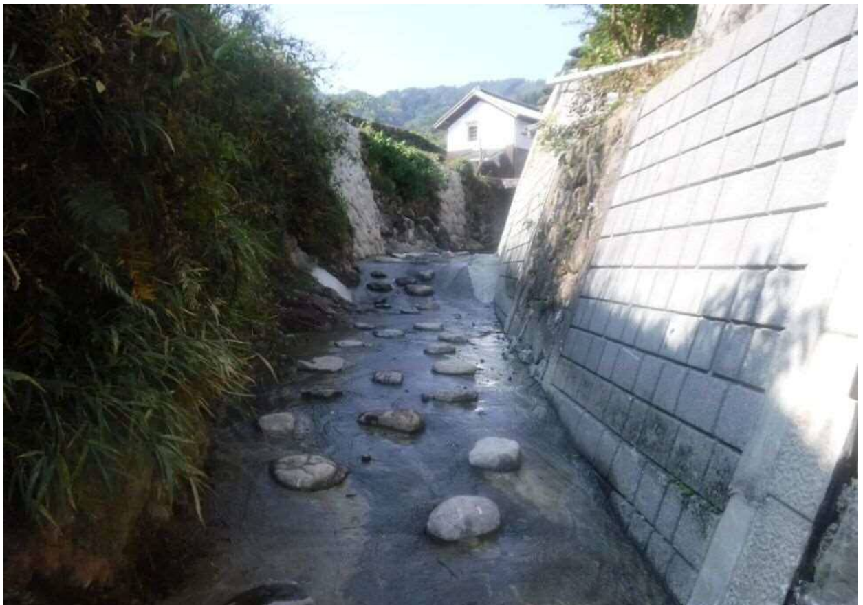
（令和3年11月単災工事完了後）
