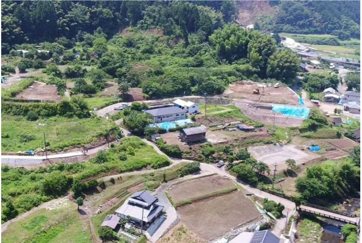
【杉堂1地区（西側）】着工前（H30.9）
