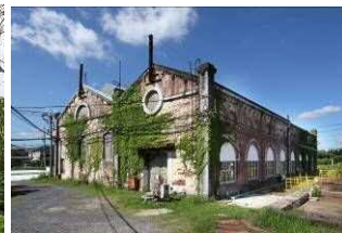
遠賀川水源地ポンプ室
