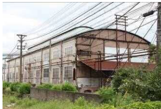
官営八幡製鐵所 旧鍛冶工場
