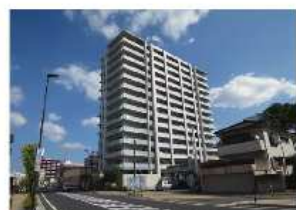
[図2] 分譲マンション(文化交流拠点地区)
