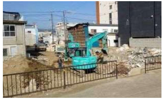
(解体工事の様子)
