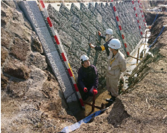
施工中の出来形確認
