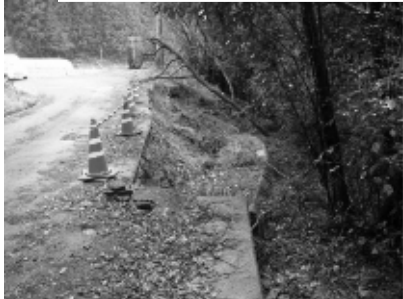
道路災 工種：ブロック積 着工前
