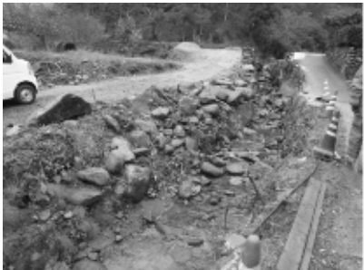
河川災 工種：ブロック積 着工前
