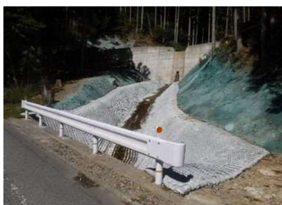
【復旧工事完了後】
