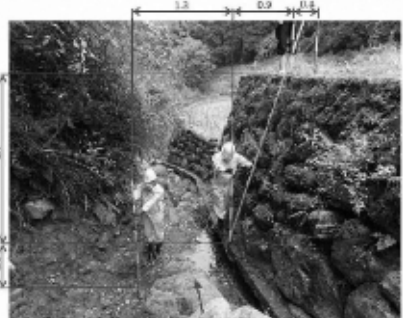
河川災 工種：ブロック積 着工前
