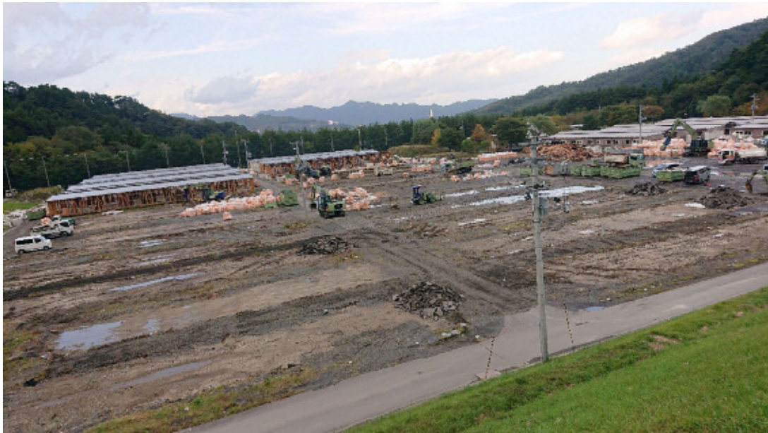
解体中の平田第6仮設団地（令和2年10月撮影）
