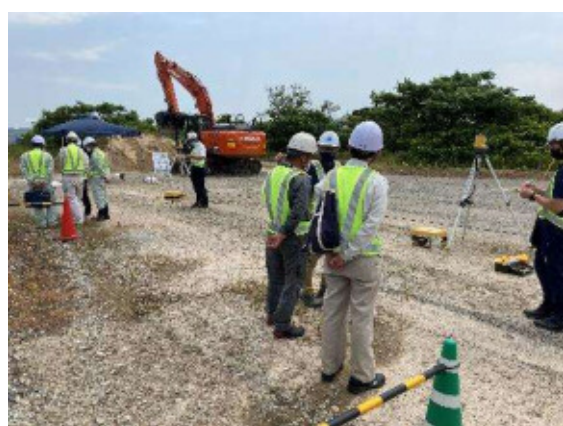
ICT測量機器等の説明状況
