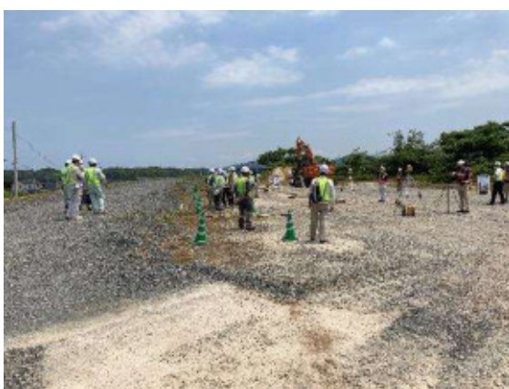
現場体験時の全体の状況
