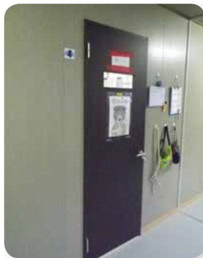
ドアに飼育舎内確認用の小窓を設置
