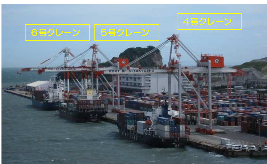
太刀浦第2コンテナターミナル クレーンの様子
