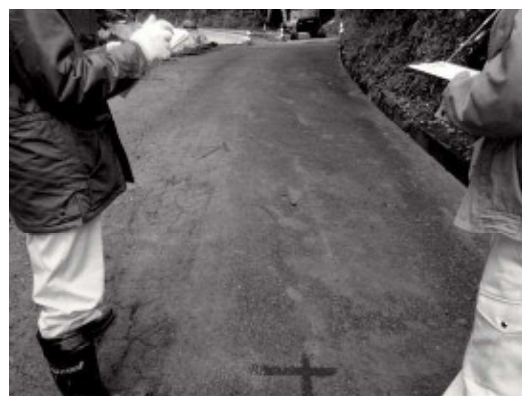
舗装復旧範囲の確認風景
