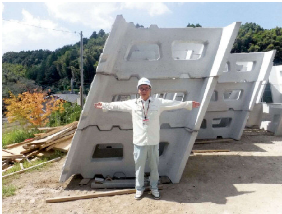
擁壁の使用材料 大型ブロック（側面）控長が2メートル（私の身長が182cm）
