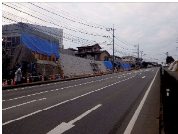
【施工中】 H31. 1 中旬
