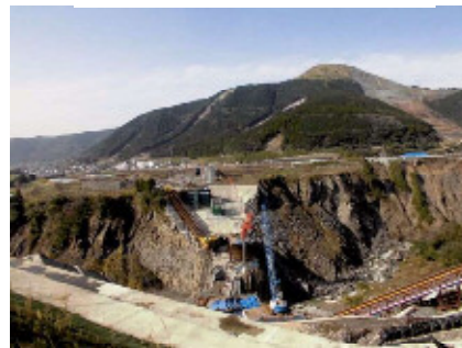
阿蘇大橋の復旧工事
