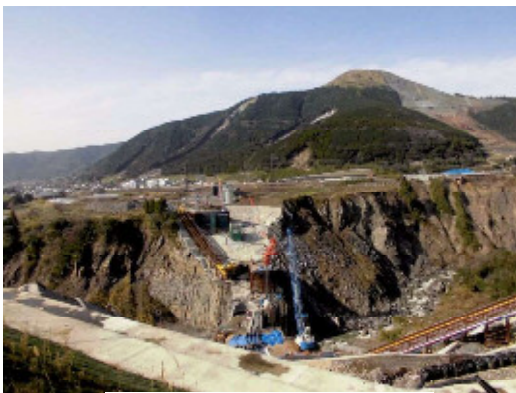
阿蘇大橋の復旧工事
