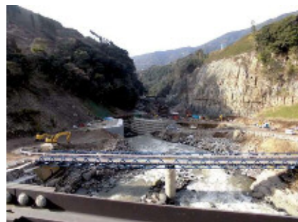
立野ダム建設工事
