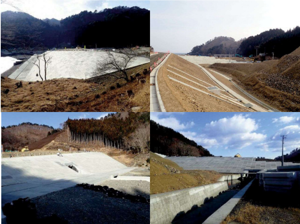
未完成の佐須防潮堤 H31. 2
