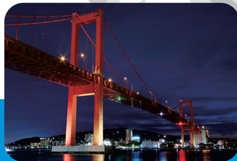
本市若松区と戸畑区を結ぶ 若戸大橋
