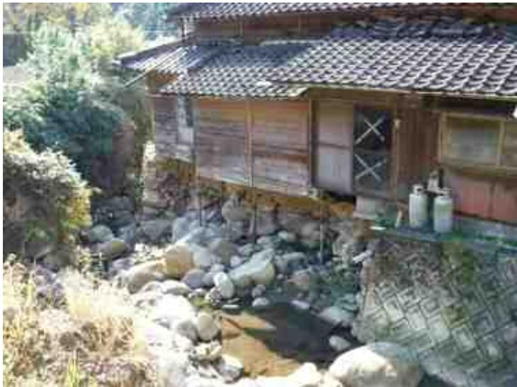
写真-1 被災した河川護岸の状況
