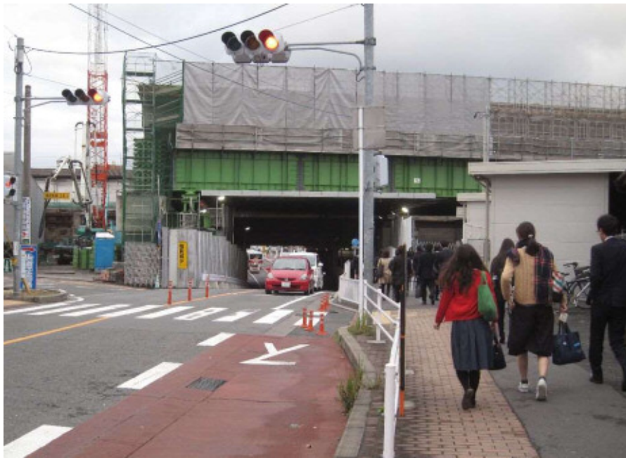
工事桁架設状況
