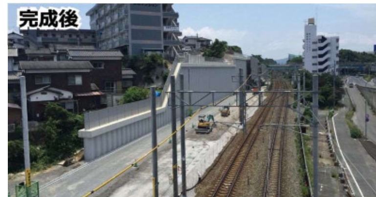
変更：鋼管杭直壁工法
