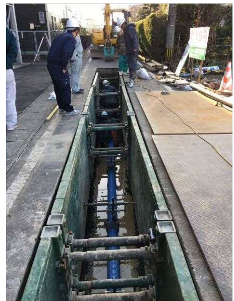
【下水道管渠災害復旧工事の様子】
