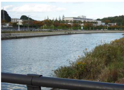
←護岸整備状況
