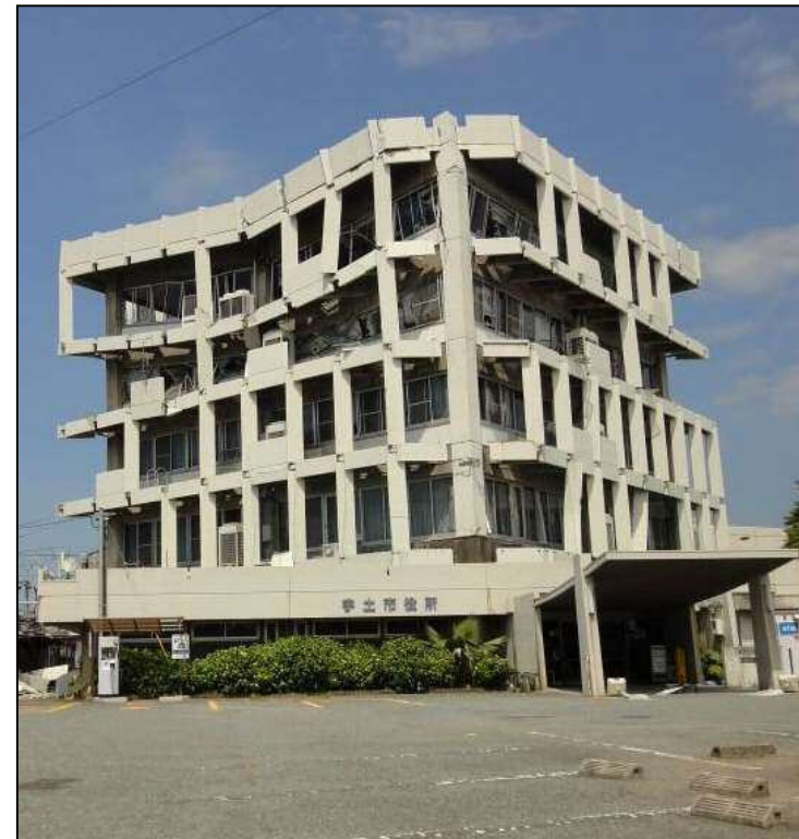
【災害時の司令塔となる市役所が被災】
