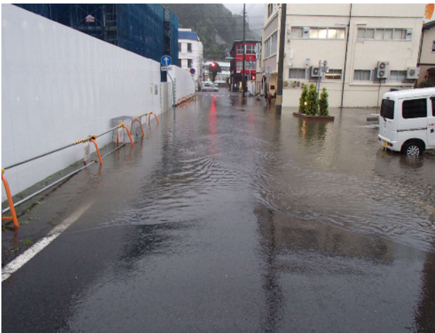
【大雨で冠水した道路】
