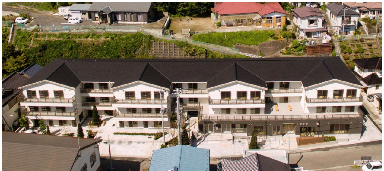
小白浜復興住宅 (鉄骨造 2 階建 : 27 戸) 平成 27 年 7 月竣工
