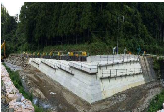
写真-4 河川護岸復旧
