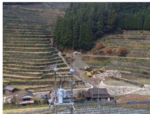
写真-3 河川護岸復旧(景観地区)
