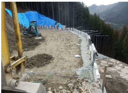
写真-2 補強土壁(多数アンカー工法)
