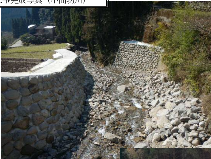
工事完成写真（小間坊川）
