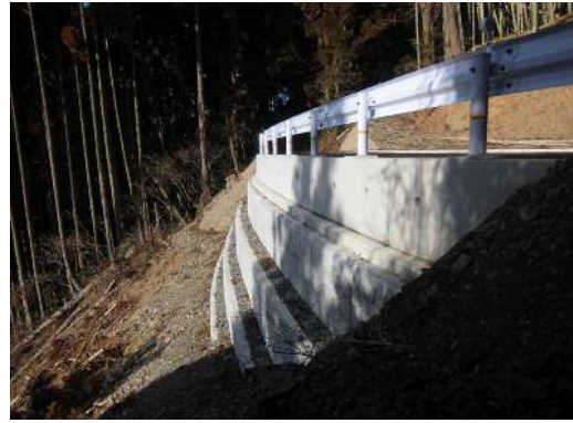
道路災害（石原・鹿子生線）完成
