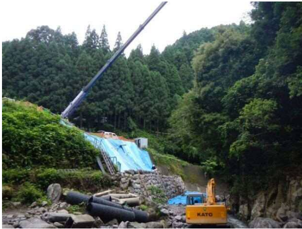
写真① クレーン作業
