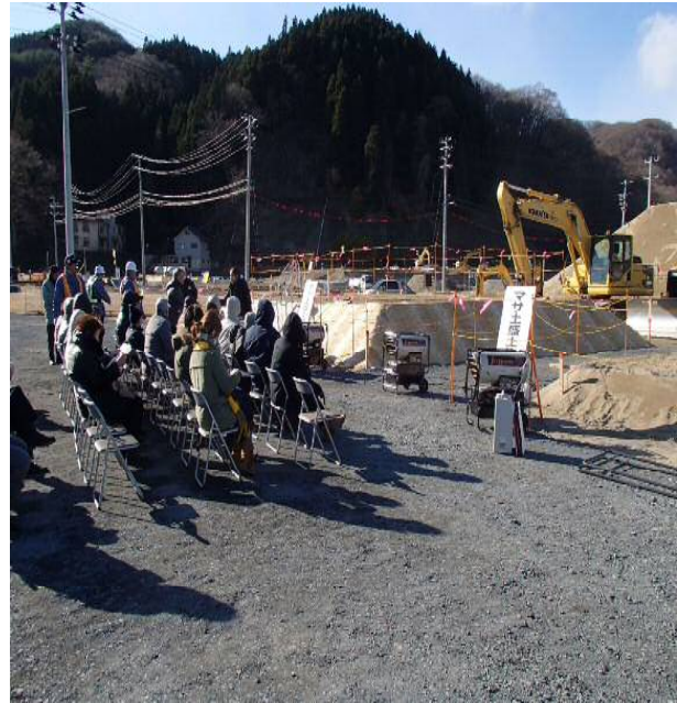
公開盛土試験
