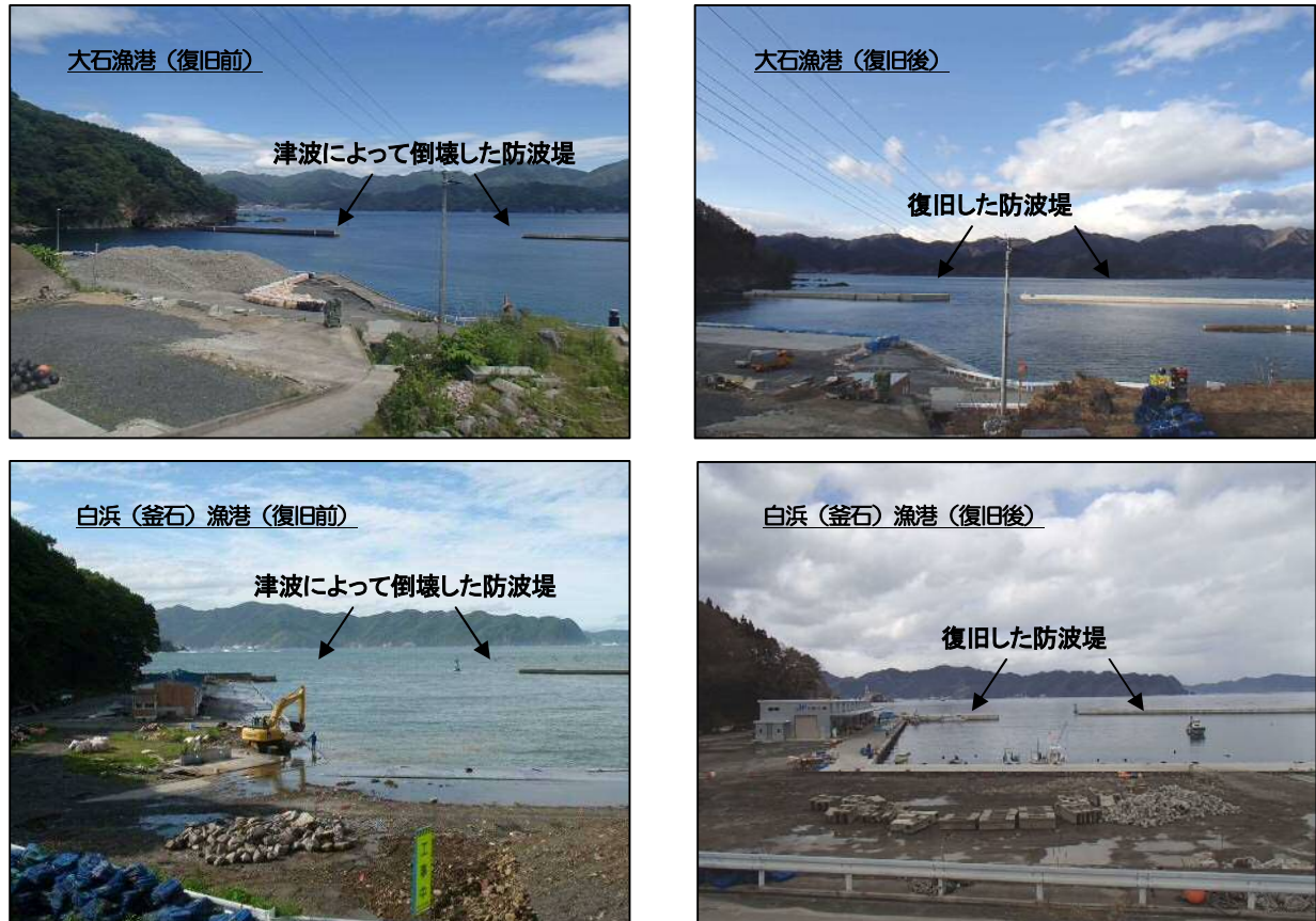
写真 4 防波堤復旧状況
