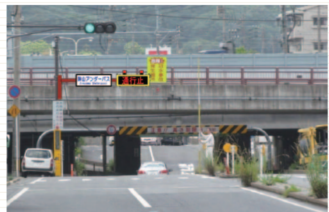
▲アンダーパスでの安全対策（冠水警報表示板設置イメージ）
