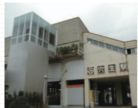
▲エレベーターが設置された穴生駅（黒崎駅方向）
