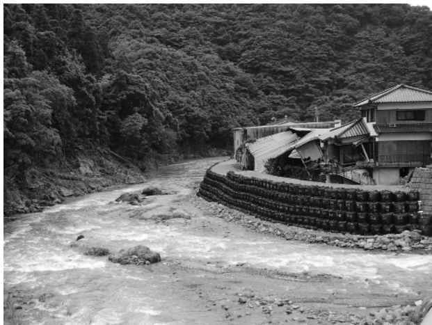
【大型土のうによる応急工事】
