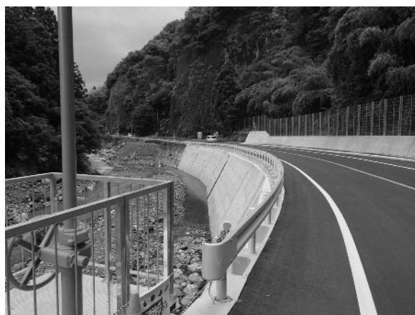
【復旧工事完了】
