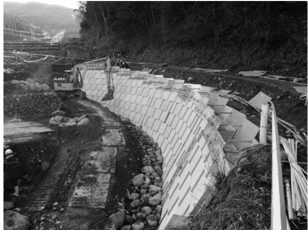
図-1. 大型ブロック積擁壁工の施工状況
