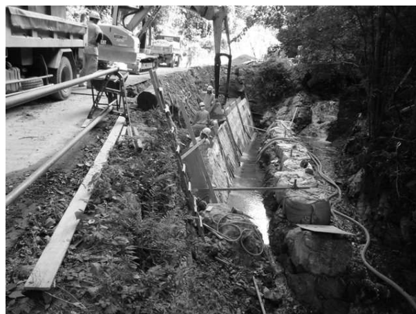
(護岸復旧工事の様子)
