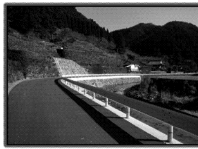
写真-③復旧状況 (白土橋)
