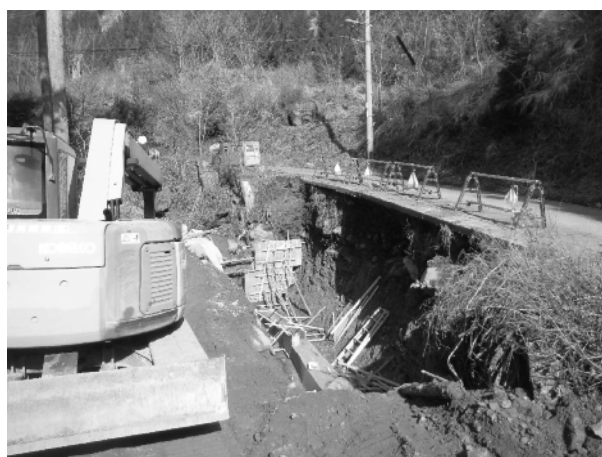
【現在施工中の現場】
