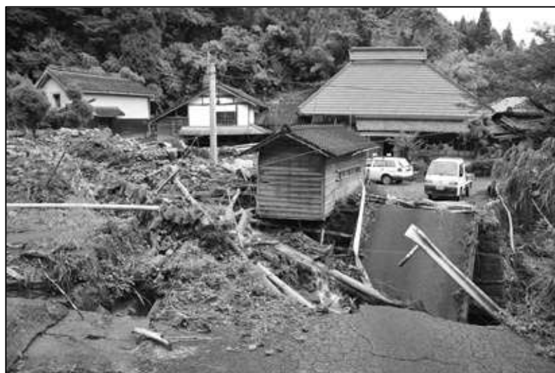
【写真 1】左側から土砂が流出し家屋が半壊している。
