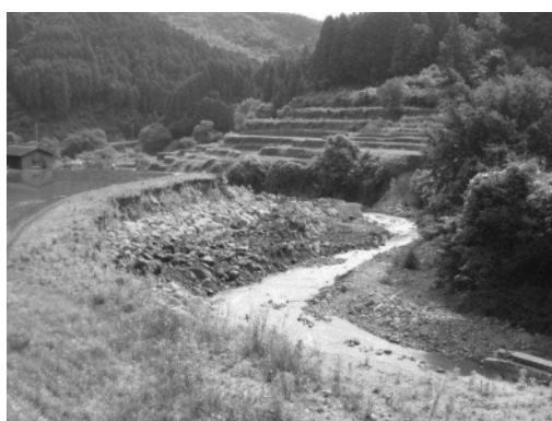
【同左箇所 JV施工 河道確保】
