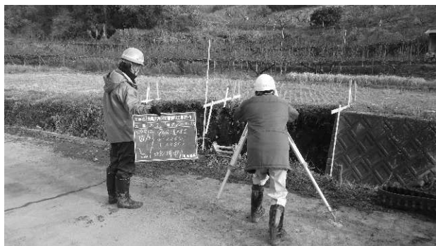
写真-3 現地立会の様子1
