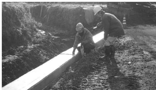
写真-4 現地立会の様子2
