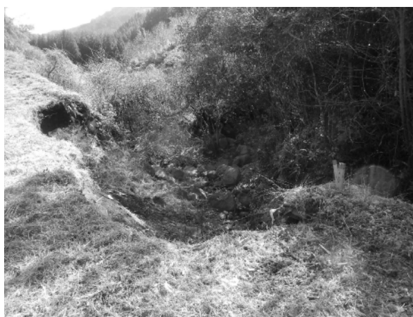
【未着手の現場】
