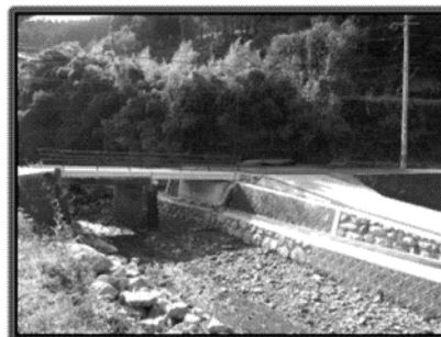
写真-③復旧状況 (白土橋)
