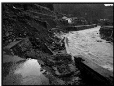
写真-②被災状況 (白土橋)
