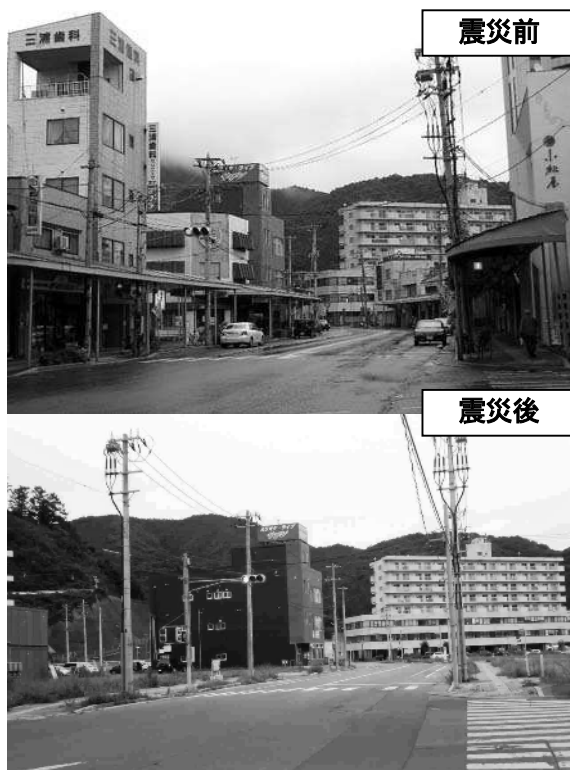
県道4号線・国道45号の高架下から東方向
