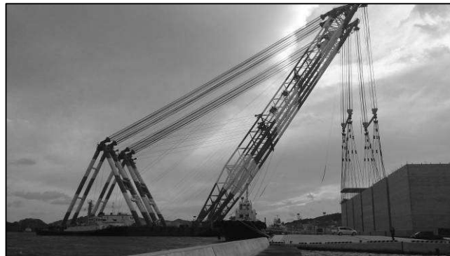
陸上製作したケーソンを吊り上げる日本最大の起重機船
