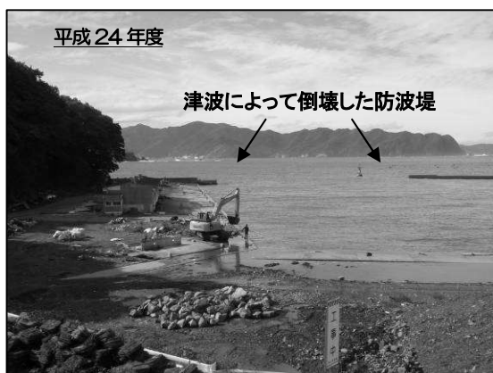
写真3 防波堤の復旧状況
