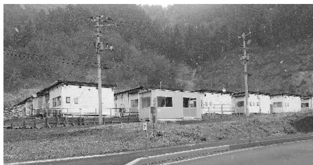
40世帯が暮らす小白浜地区仮設団地
