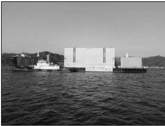
三重県からデッキバージで輸送されるケーソン
