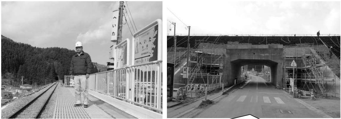
既設車道の両側に歩道を整備するため、盛土構造の線路を開削して施工したもの
