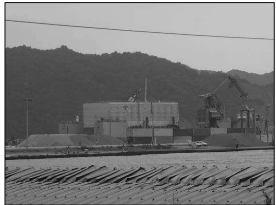
釜石港に接岸されたケーソン
