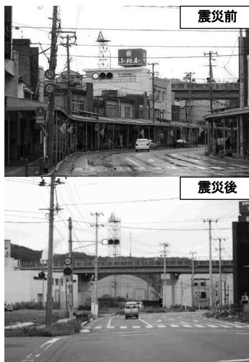
市営ビル前バス停付近から西方向
