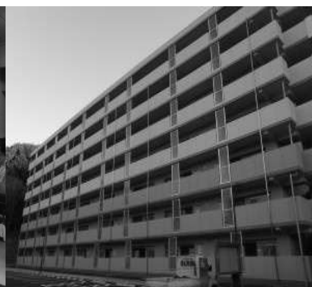
【復興住宅：県営平田アパート】
