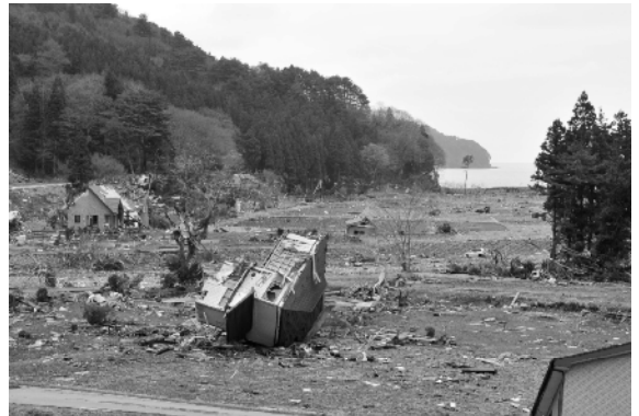
【唐丹町荒川地区の被災状況 ：後に災害危険区域に指定】
