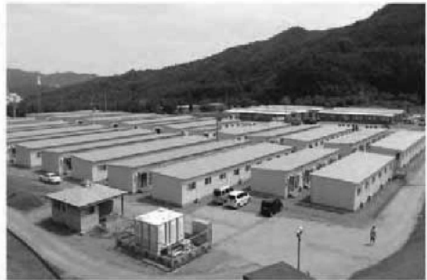
平成23年8月10日(日) 平田第6仮設団地、41棟、240世帯を設置
