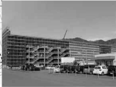
イオンタウンの工事状況 H25. 12月撮影
