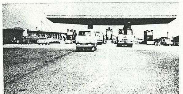
若戸大橋料金所
