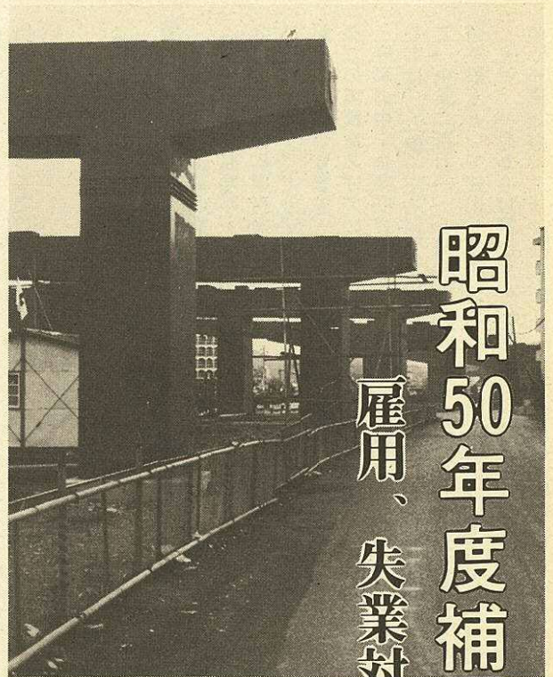
建設中の都市高速道路
