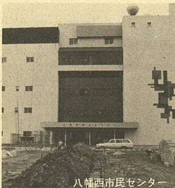
八幡西市民センター
