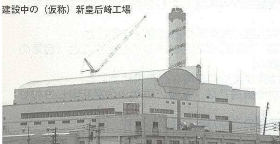
建設中の（仮称）新皇后崎工場
