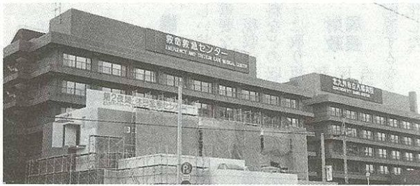
建設中の第2夜間・休日急患センター
