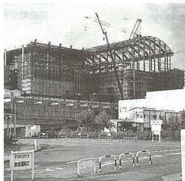
建設中の（仮称）新皇后崎工場
