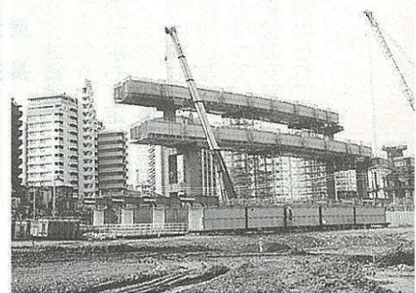
都市高速道路延伸工事
