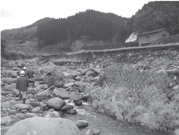
（設計図面を基に現地を確認）
