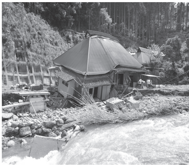
【河川増水して避難途中で亡くなられた家】
