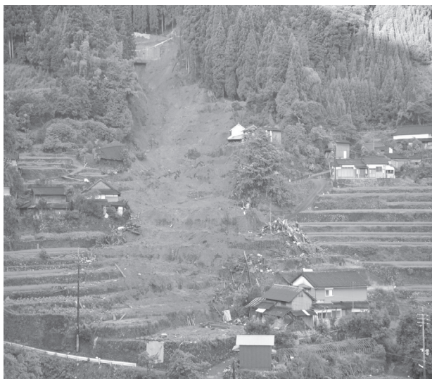
【土砂災害で家屋被害があった箇所】
