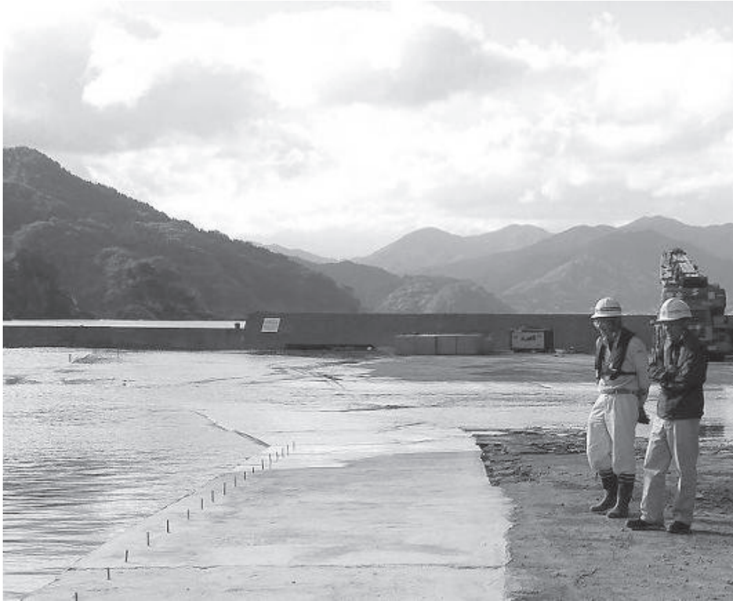
■ 施工中の物揚場・・・満潮時にはどこから海か分からない・・・
