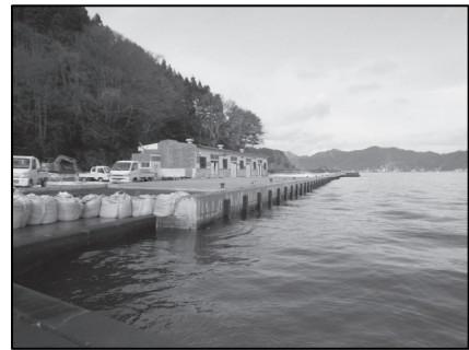
写真5 白浜(釜石)漁港 竣工写真
