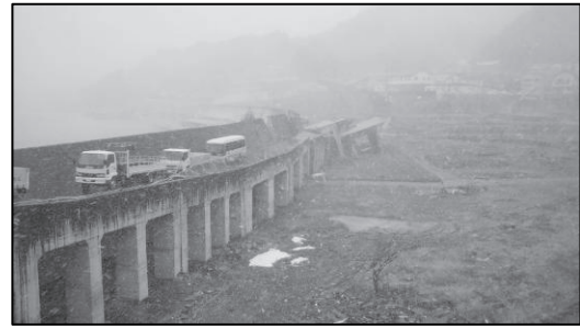
津波によって倒壊した防潮堤
