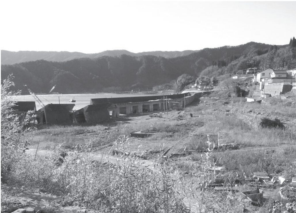
津波で転倒した防潮堤
