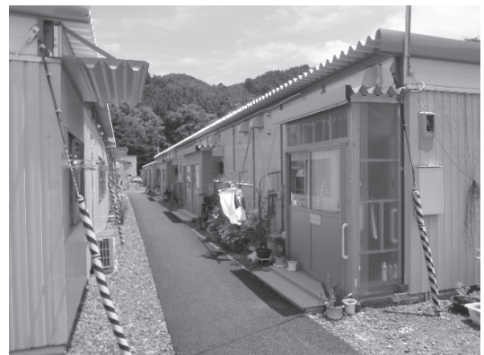
北国ならではの仮設住宅（玄関は風除室付）
