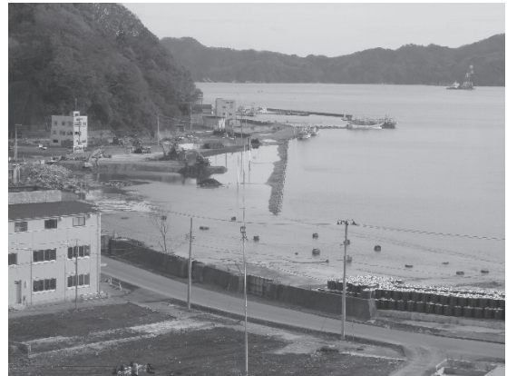
浸水する護岸（浜町、大型船の乗揚げ場所）
