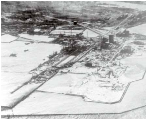
大拡張中の八幡製鉄所戸畑製造所（当時）
