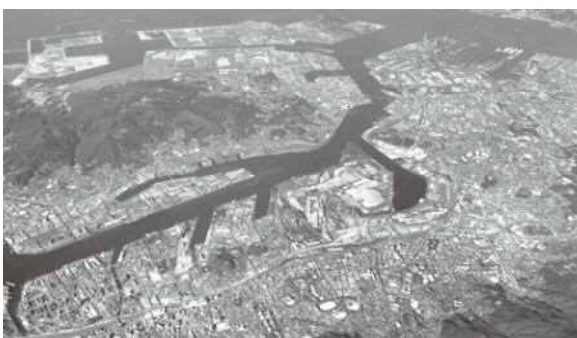
現在の日本製鉄九州製鉄所（八幡地区）（日本製鉄株式会社提供）
