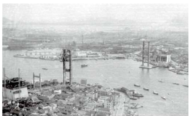
けんせつちゆう わかとおおし ねん 建設中の若戸大橋(1961年ごろ) ねん しょうわ ねん かんせい どうじ どうよういち おお 1962年(昭和37年)完成。当時は、東洋一の大きさ のつり橋でした。
