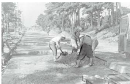
1958年（昭和33年）明治学園前の道路 工事
