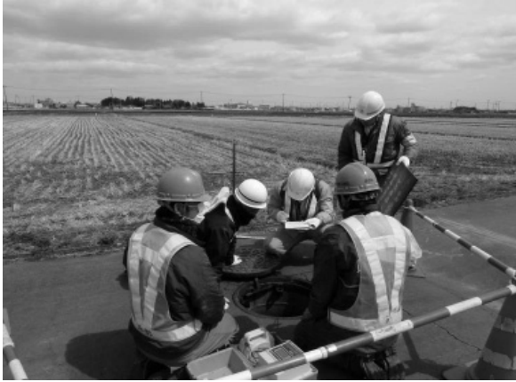
4月3日 ①下水道管渠第二次調査 ※人孔被災状況の確認
