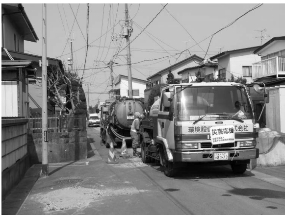
4月12日 ⑨下水道管渠の第二次調査 ※ テレビカメラ調査状況
