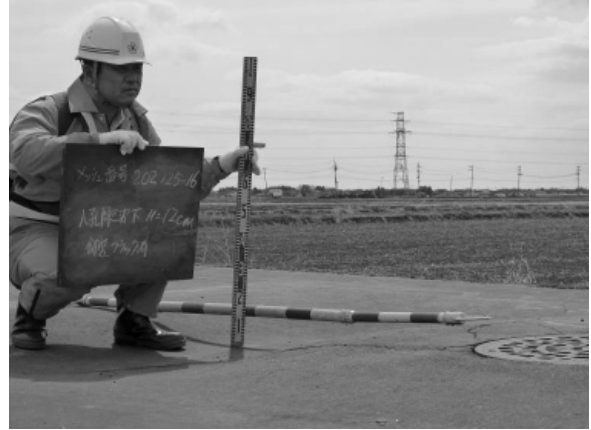
4月3日 ④下水道管渠第二次調査状況 ※人孔周辺の沈下状況測定
