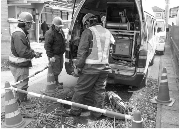
4月3日 ⑦下水道管渠第二次調査状況 ※不具合管渠のテレビカメラ調査
