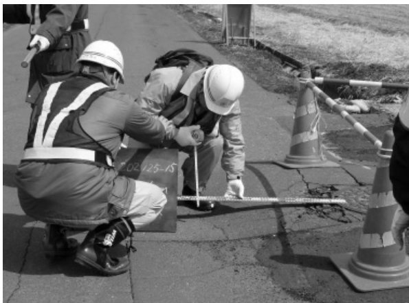
4月3日 ③下水道管渠第二次調査状況 ※人孔周辺の沈下状況測定
